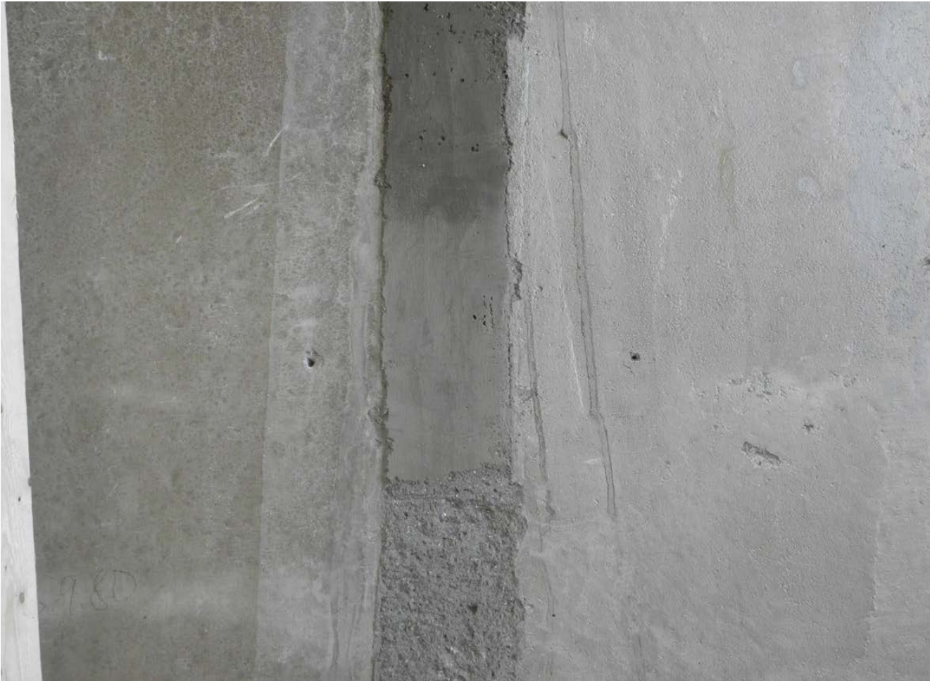
Muotilla valettu pystysauma. Kuva Keijo Neffling
