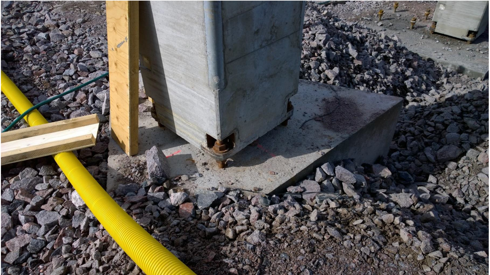
Pilarin alapää alkutilanne. Kuva Keijo Neffling
