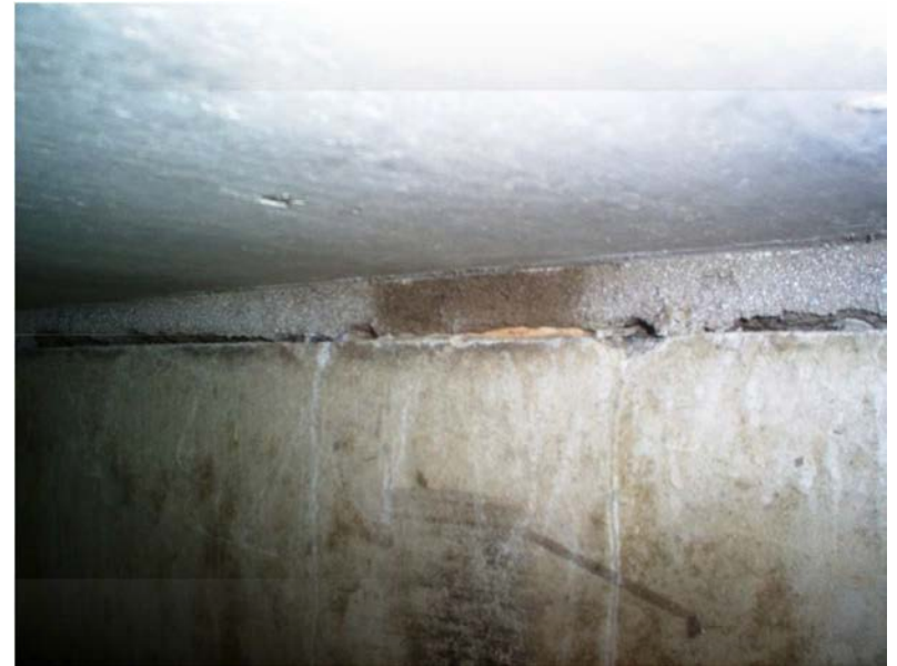
Yläsauma jää usein vajaaksi. Kuvat Timo Rautanen
