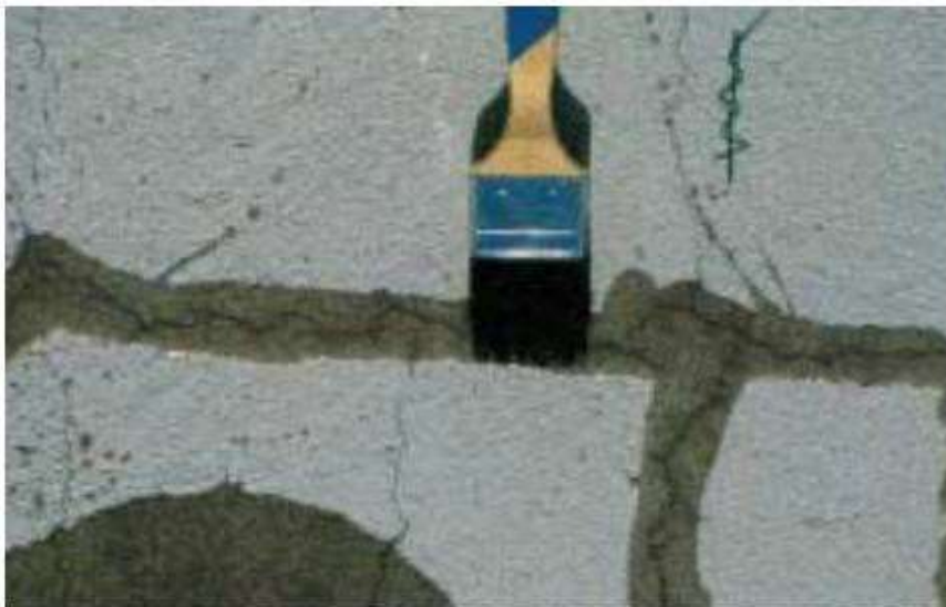
Kuva 5. Imeytysaine pidetään liikkeessä siveltimellä (vaihe 2).
