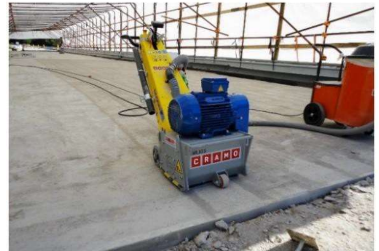
Kuva 5. Ohuen pintakerroksen poistamiseen sopiva jyrsin.
