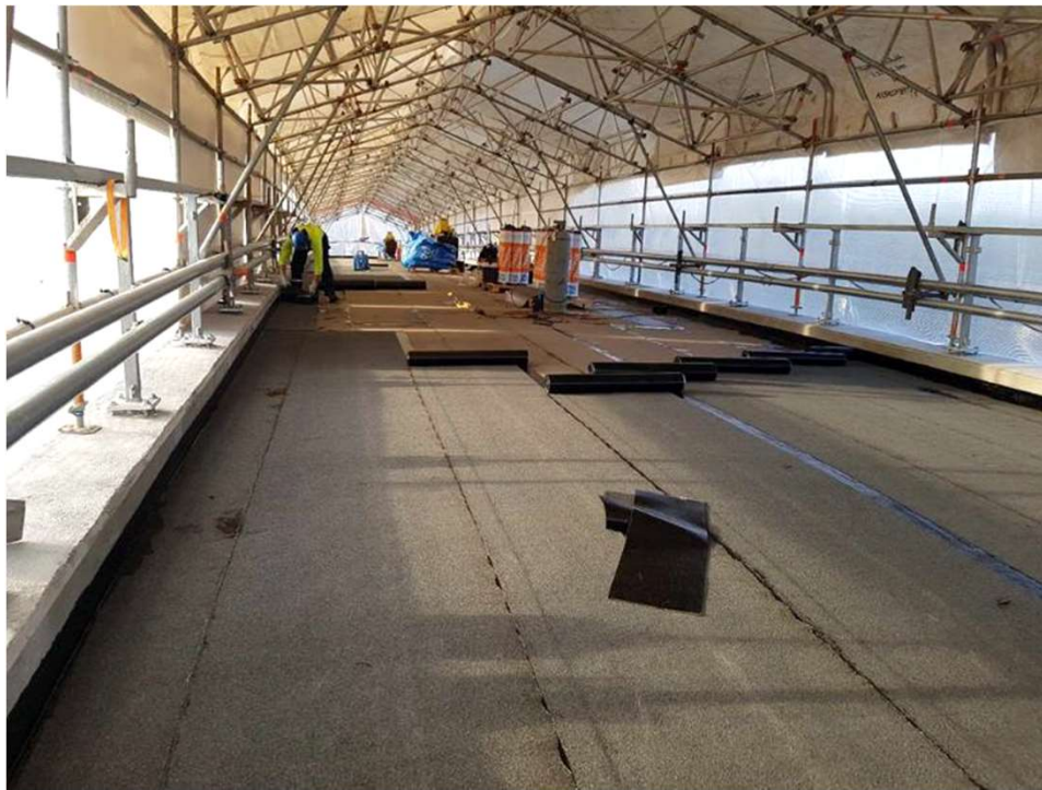
Hyvin asennetut ja limitetyt kermit.
