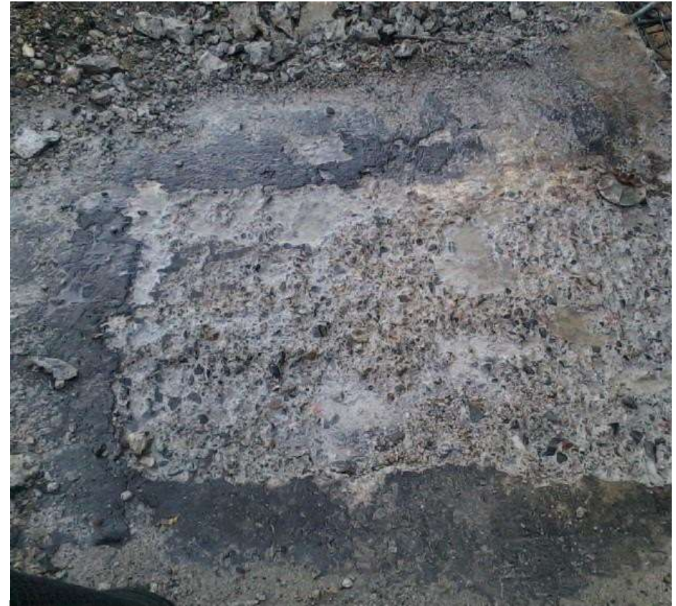
Koepiikkaus, tummat alueet ovat vanhaa vedeneristystä.
