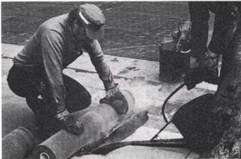
Kuva 1. Kermieristyksen tekoa liimaamalla.
