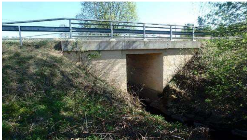
Orijärvenpuron silta, kannen pinta-ala 19 m 2 .
