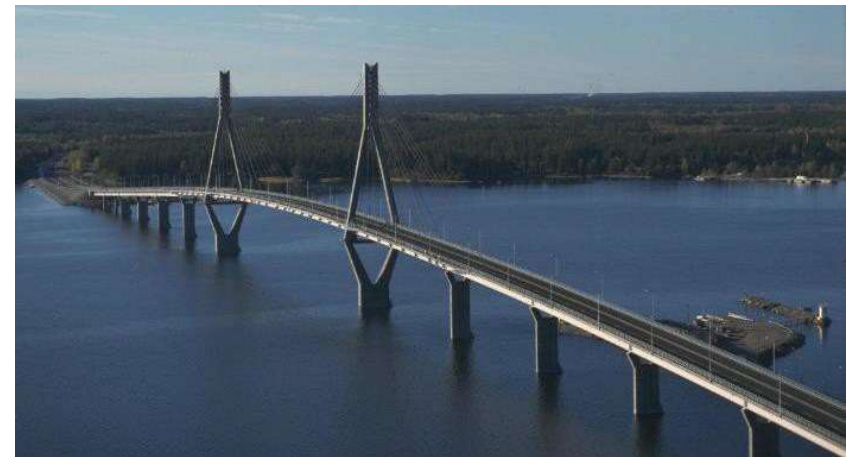
Raippaluodon silta, kannen pinta-ala 13 216 m 2 .
