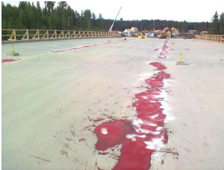
Tippuputkilijojen kallistukset korjattu.
