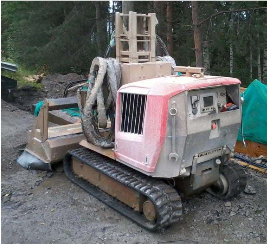
Rapautuneen betonin piikkaukseen käytettävä robotti. Vedenkulutus 10–12 m 3 tunnissa.
