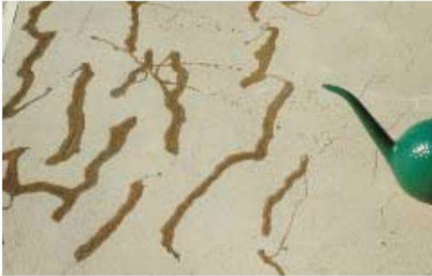
Kuva 4. Imeytysaine on kaadettu halkeaman päälle (vaihe 1).
