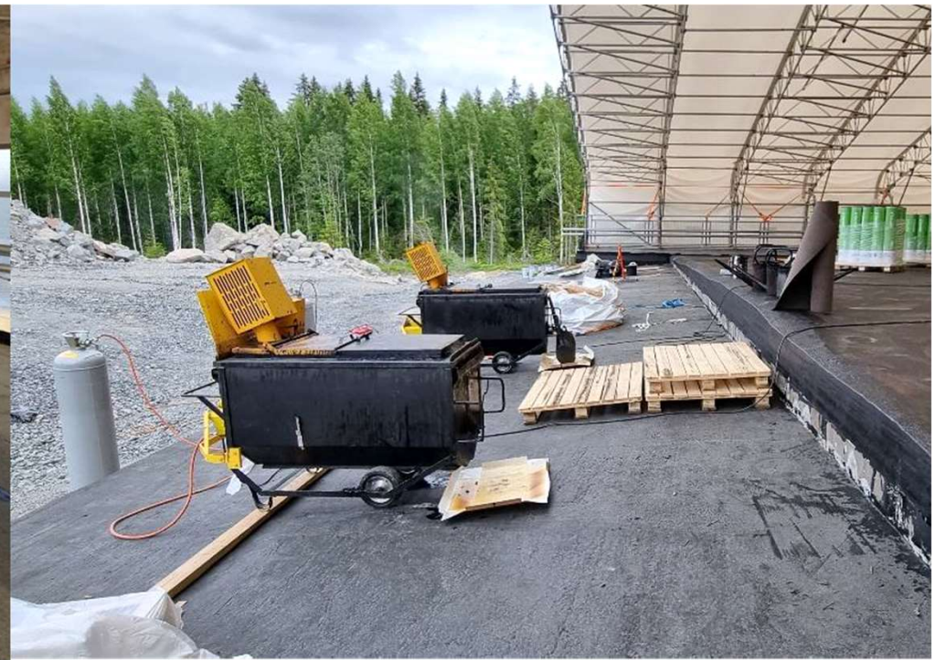
Bitumipataa ei saa viedä sääsuojan sisälle. Padasta vapautuvien savukaasujen on arveltu olevan terveydelle haitallisia.
