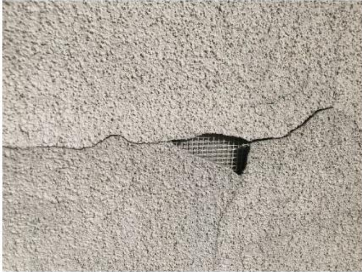
Kuvat 4 ja 5. Rappauspinnan irtoamista vasemmalla ja hiushalkeama oikealla.
