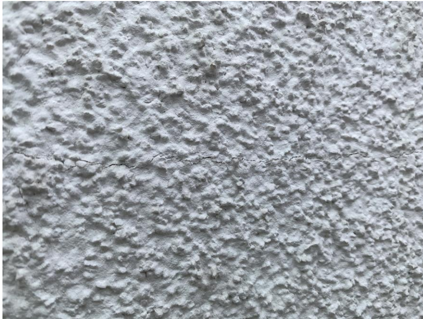
Kuvat 4 ja 5. Rappauspinnan irtoamista vasemmalla ja hiushalkeama oikealla.
