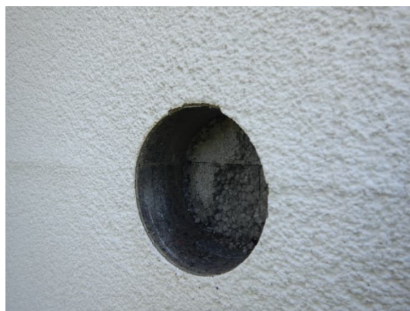
Kuva 6. Halkeaman kohdalta otetussa näytteessä HT1 halkeaman taustalla on kuorikiven vaakasauma.
